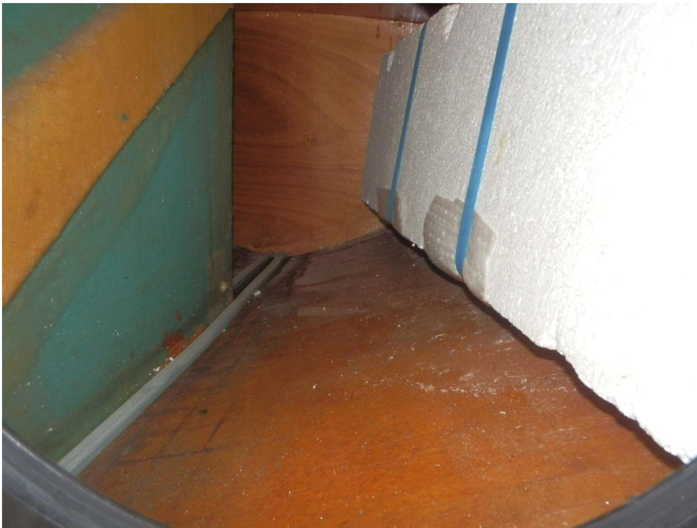
Mellom stasjon 2 og 3 med nytt skott ved stasjon 3 og dreneringsslang.
